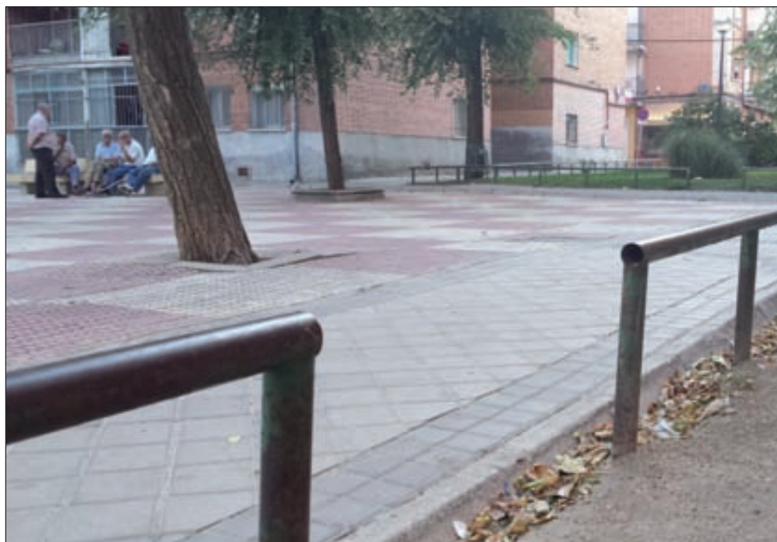
Plaza de los Ríos, con trozos de vallas rotas
