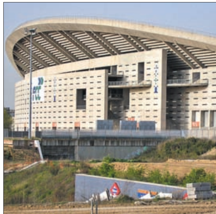
Estación de Metro de Estadio Olímpico
