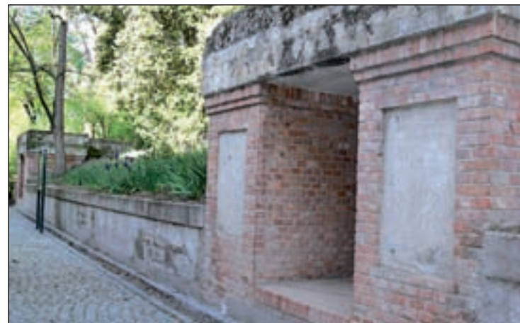
Entrada del búnker, construido como refugio en 1937
