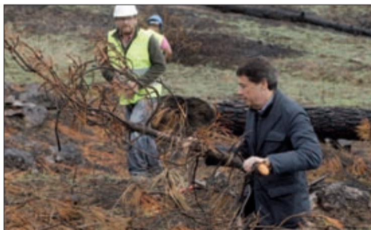
Ignacio González supervisando los trabajos de limpieza
