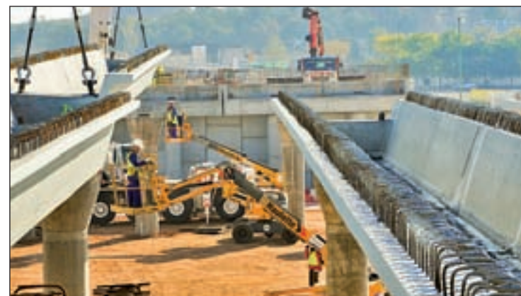
Las obras suponen una inversión superior a los 34 millones de euros
