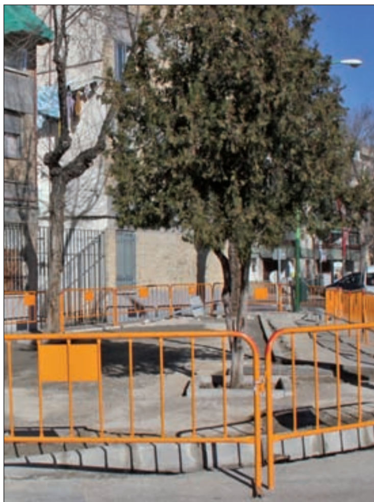
Las obras de El Nido avanzan a buen ritmo
