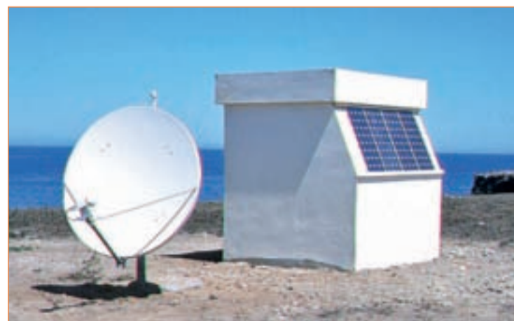
Estación de medición sísmica en Alborán RED SÍSMICA ESPAÑOLA
