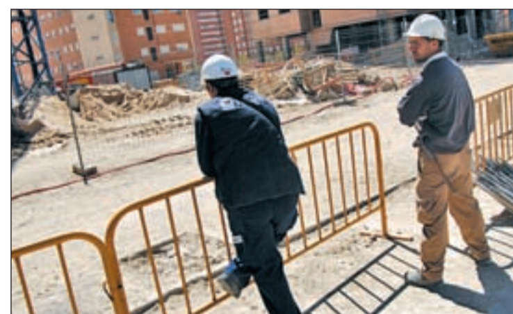
Dos obreros de la construcción en su puesto de trabajo
