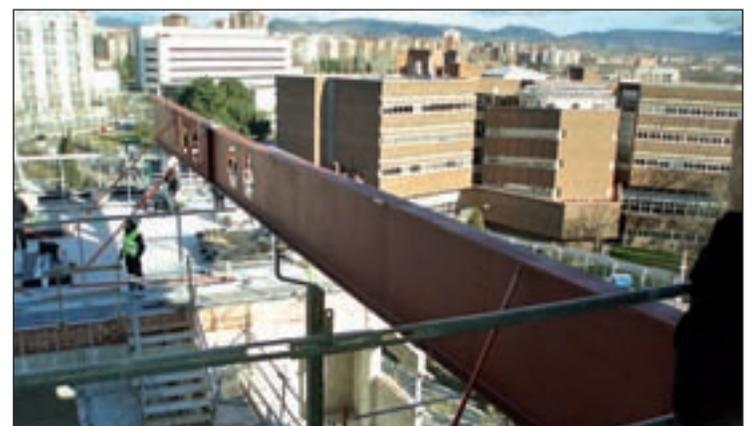
Viga instalada para el helipuerto del nuevo edificio del CHN. GOB. NAVARRA
