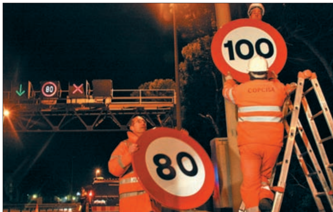
La contaminació no ha permès eliminar com estava previst la limitació dels 80 km/h ACN
