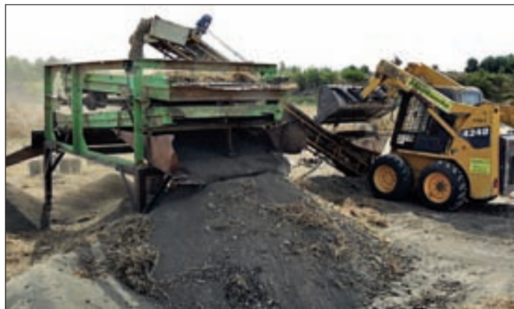
Los trabajos se prolongarán durante tres meses
