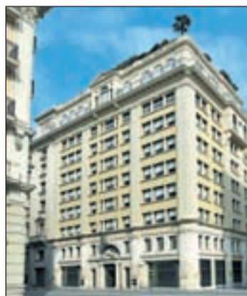
Fachada del hotel
