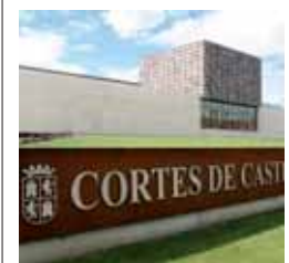
Fachada principal de la Cortes.
