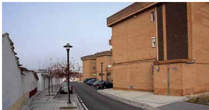
Imagen de una de las calles del barrio del Cristo de la capital donde se han llevado a cabo estas obras.
