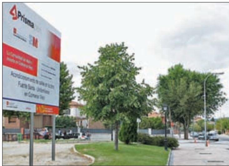
Las calles presentan una nueva imagen tras las obras de mejora
