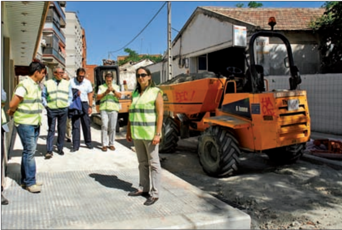
El alcalde de Valdemoro José Miguel Moreno visitó las obras esta semana
