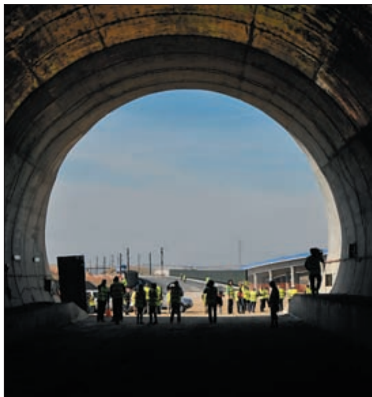
Obras de un túnel en el trayecto del AVE a Valencia OLMO GONZÁLEZ/GENTE
