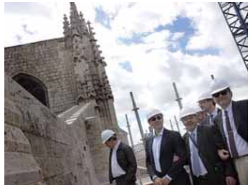
Gonzalo Jiménez durante su visita a las obras de la Catedral palentina.
