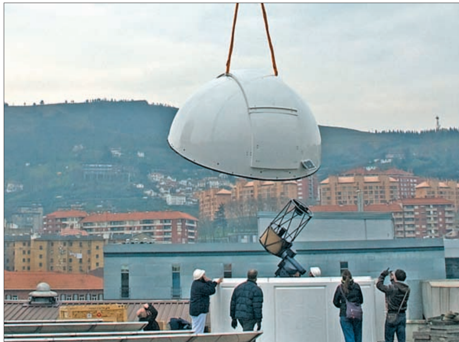
Varios operarios colocan la cúpula metálica sobre la azotea de la Escuela Técnica Superior de Ingeniería de Bilbao
