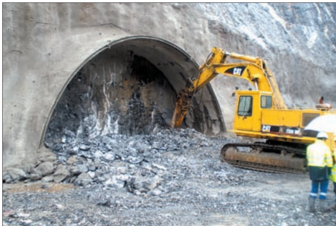
Una grúa excava uno de los túneles para el TAV
