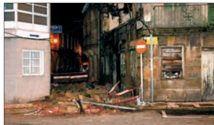
Calle cortada tras el derrumbe de la fachada en Tomás Alonso
