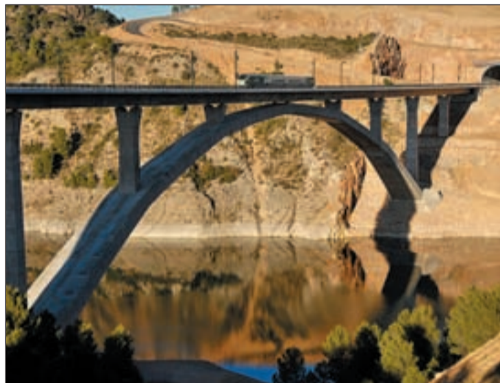
Arco del Viaducto de Contreras OLMO GONZÁLEZ/GENTE
