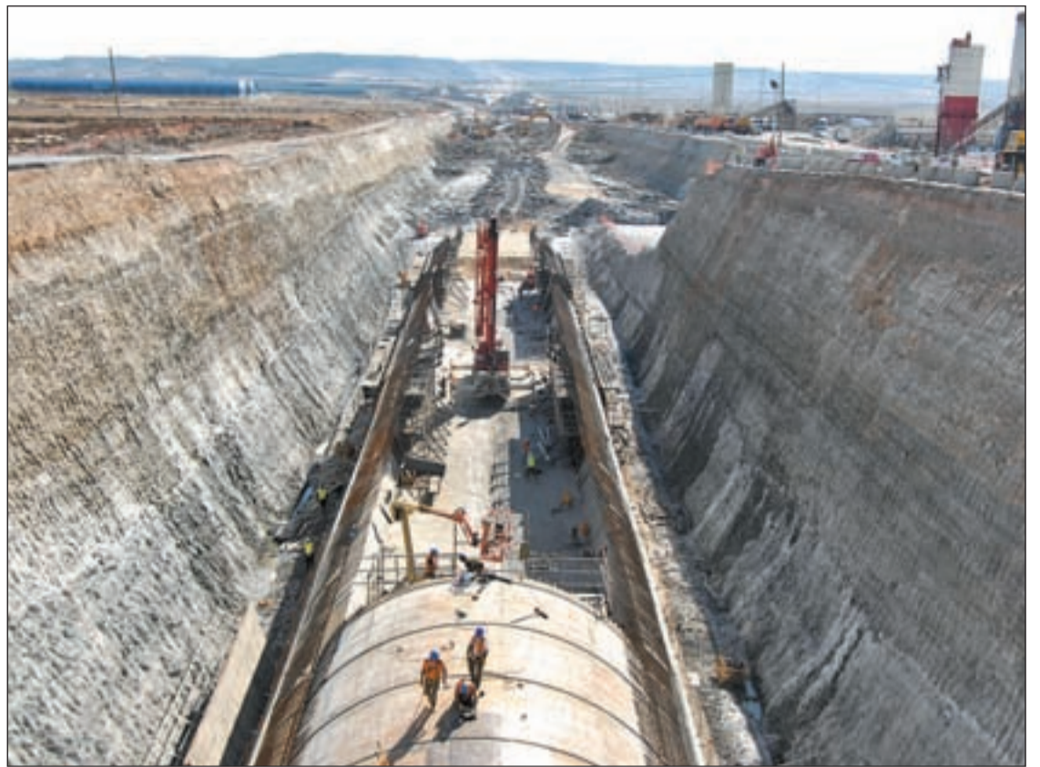
Estado de las obras del túnel del Regajal OLMO GONZÁLEZ/GENTE
