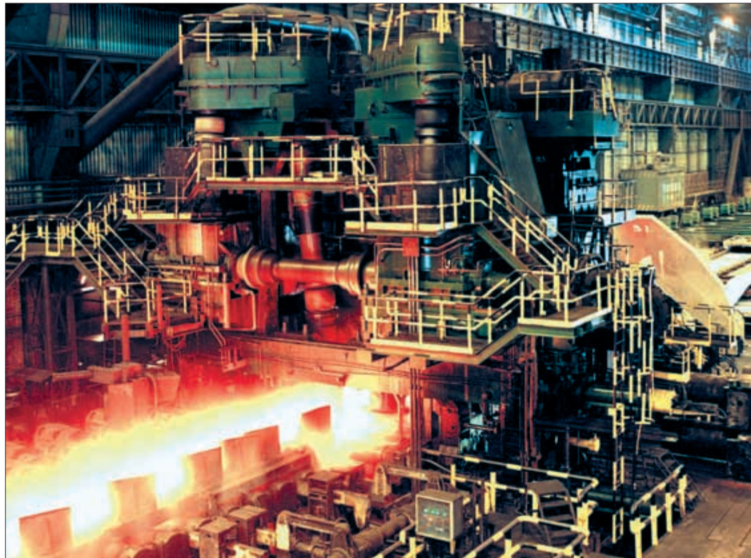
Interior de las instalaciones de la acería de ArcelorMittal en Avilés
