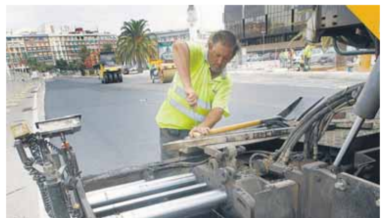
Un operario trabaja en el asfalto de meta del circuito valenciano. /EFE
