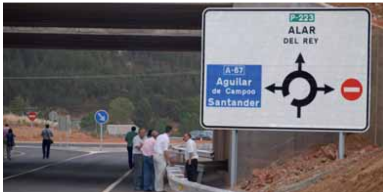
Ingenieros observan las obras de recogida de agua de la autovía a su paso por Alar del Rey.
