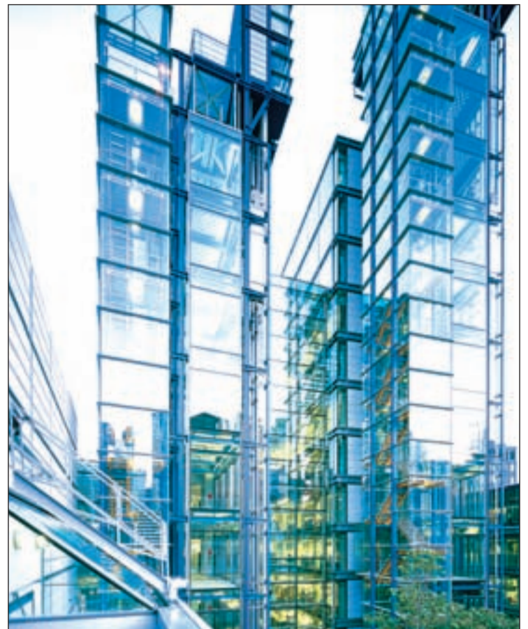
Vista del edificio Lloyd's de Londres proyectado por Richard Rogers
