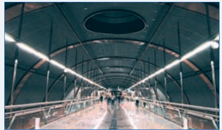
LA MÁS GRANDE DEL MUNDO La caverna de andenes del Cercanías de Sol es la mayor del mundo. Mide 207 metros de longitud, 20 de ancho y 15 de alto. En ella cabría Torre Picasso tumbada
