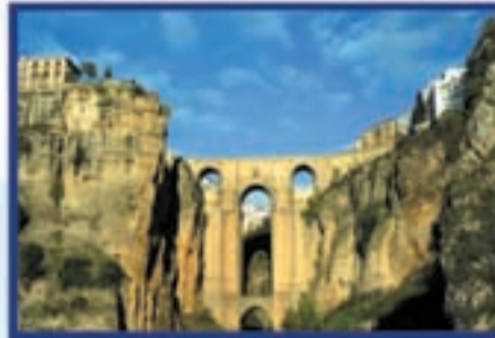
Puente Nuevo - Ronda
