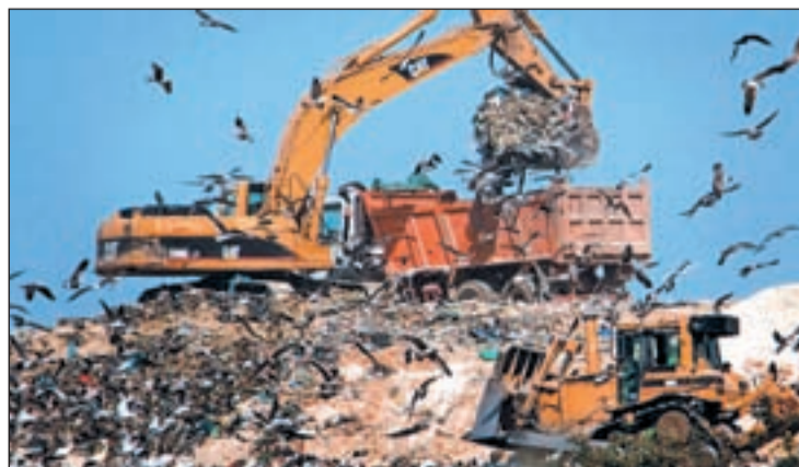
Maquinaria en la planta de residuos
