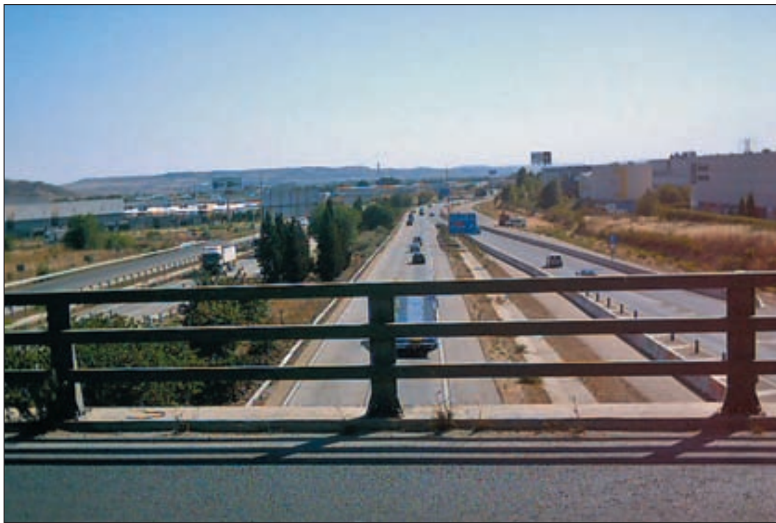
Tramo de la carretera, a la altura de Alcalá de Henares
