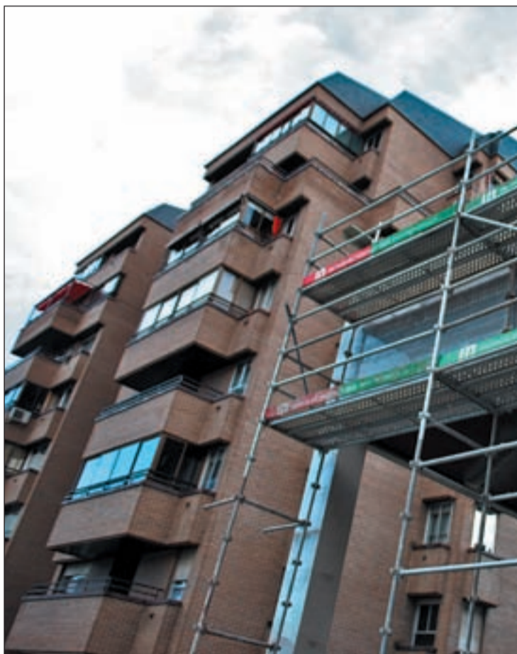
Un edificio tricantino en obras MANUEL VADILLO/GENTE
