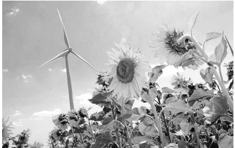
La instalación del parque eólico de Fuentes de Valdepero está constituida por 15 aerogeneradores.
