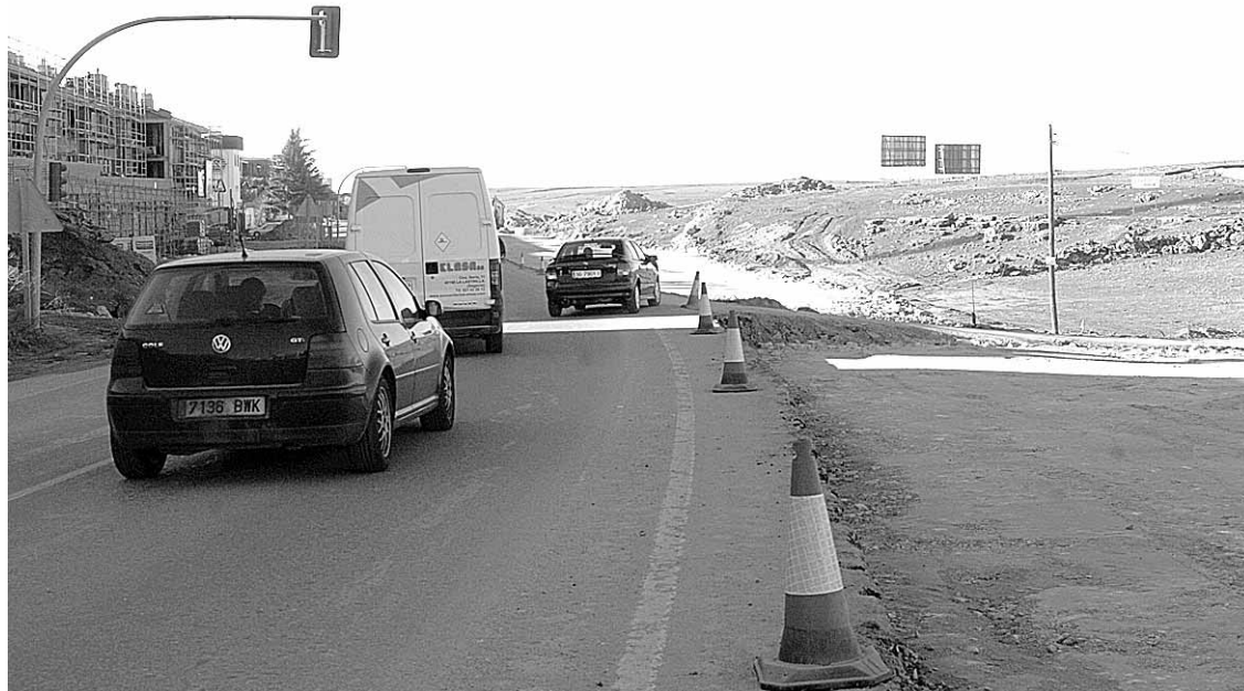
Los primeros kilómetros de salida desde Segovia ya están en obras y los trabajos concluirán el próximo otoño.
