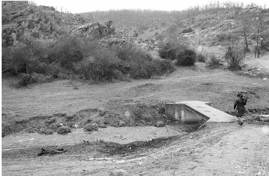
Vista de un tramo de la ribera del Río Riaza en la que se están realizando labores de trabajo.
