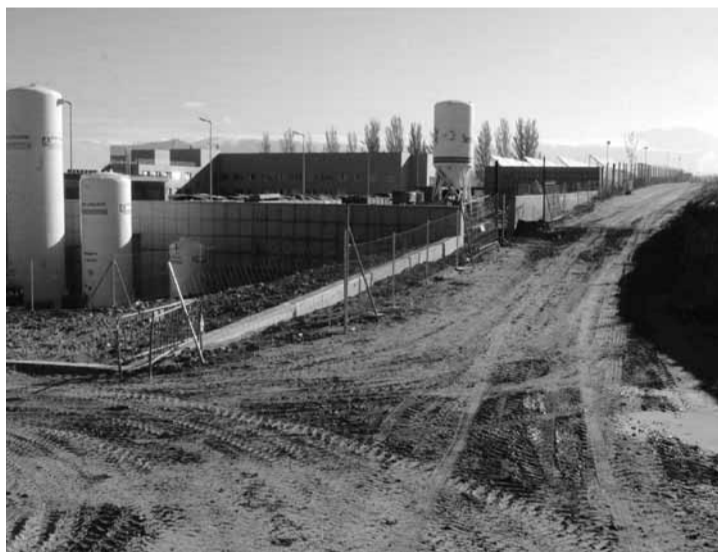
Aspecto actual de los accesos al Hospital General.
