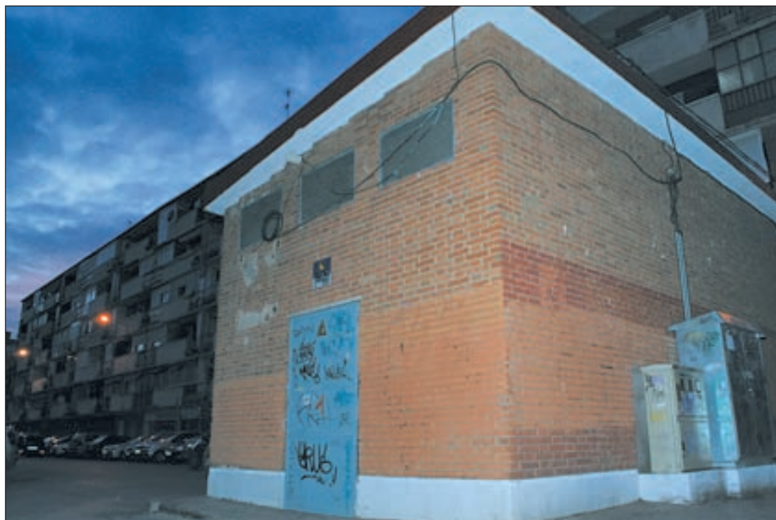
Centro de transformación de energía eléctrica en la calle Alfonso X el Sabio ORKATZ ARRIAGA/GENTE
