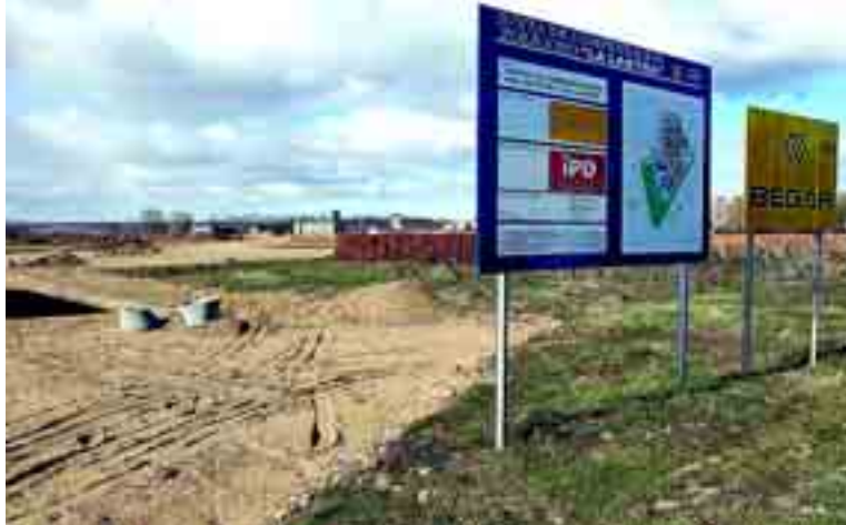
En este solar del polígono de La Lastra se levantarán 4.625 viviendas, la mayor apuesta urbanística de la ciudad.
