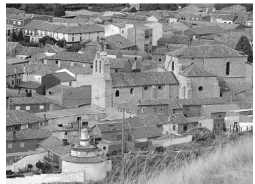
Ruiz se acercó hasta Monzón de Campos para visitar las obras.
