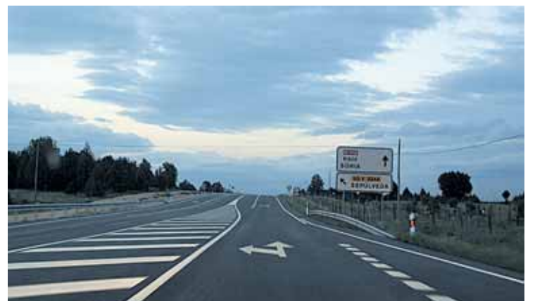
Está será la segunda actuación de Fomento en la carretera N-110.
