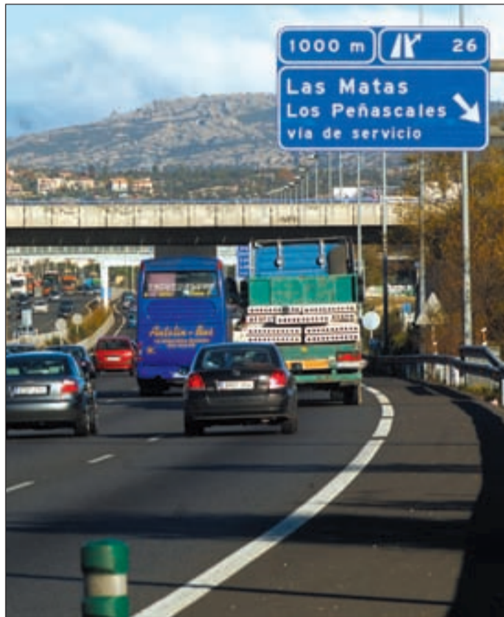
Este puente que conecta a Las Matas será derruido CHEMA MARTÍNEZ/GENTE
