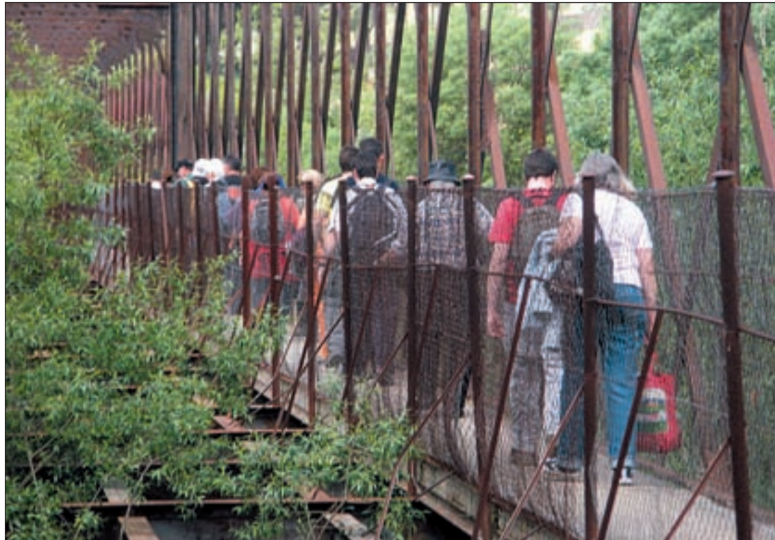
La malla del puente de Guadarrama ha sido reparada
