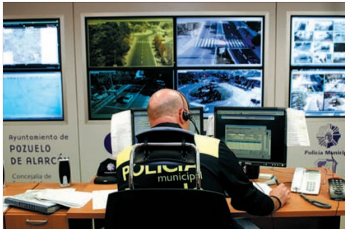
Sala de control en la nueva sede de la Policía Municipal de Pozuelo MANUEL VADILLO/GENTE
