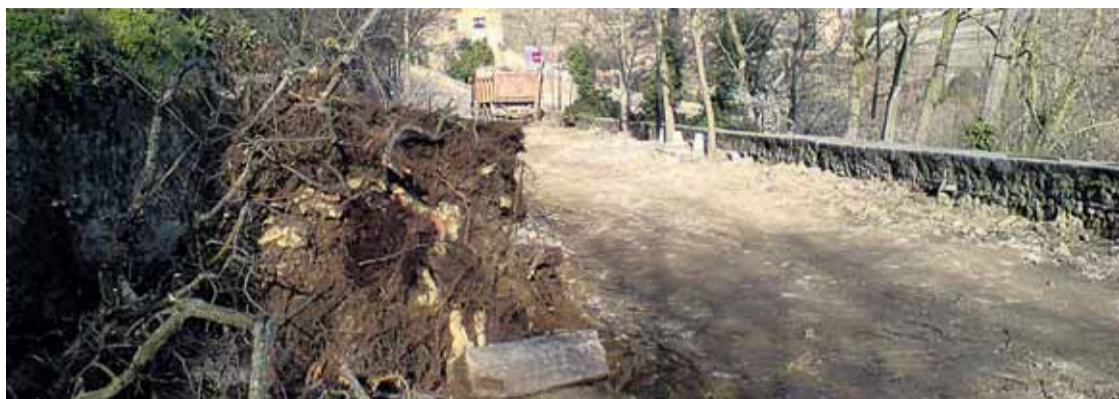
La pavimentación del Paseo de San Juan ya ha sido totalmente levantada y las acacias, desarraigadas.
