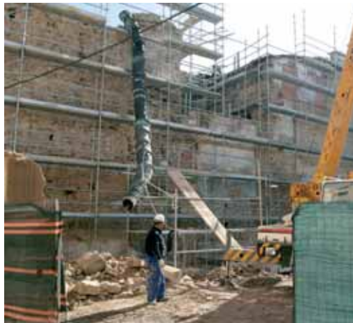
Aspecto actual de las obras en los solares Ruavieja 18c y 20.
